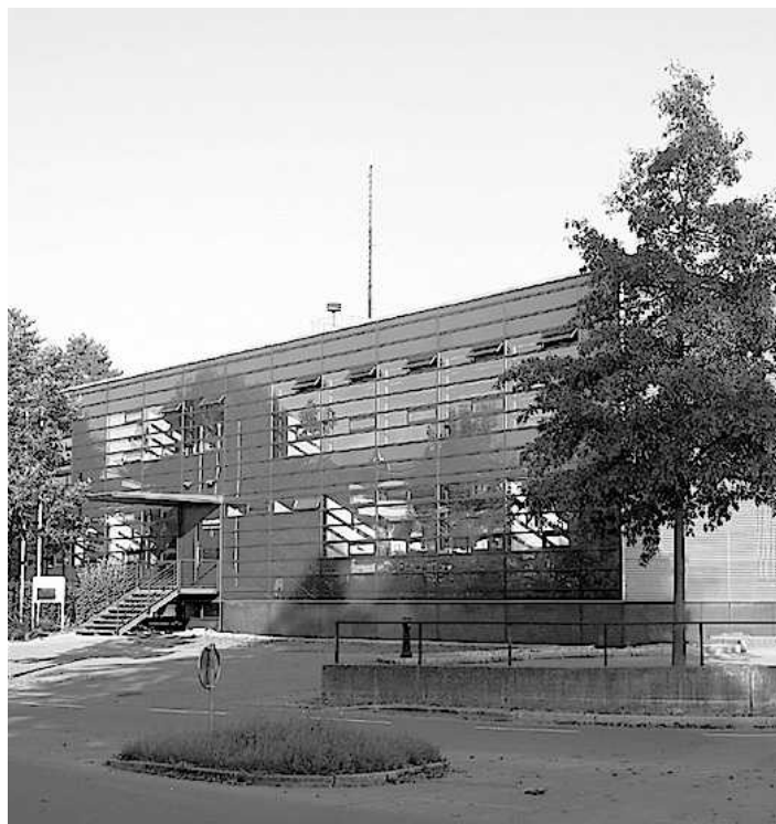
Die Feuerwehr Zentralwache ist einer von mehreren Notfalltreffpunkten im Fall eines Blackouts.
