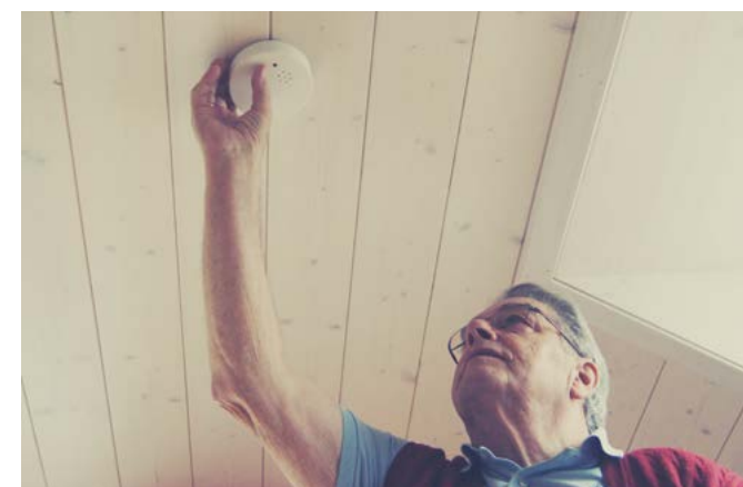
INSTALLIEREN SIE RAUCHWARNMELDER VOR ALLEM IN RÄUMEN, DIE ALS FLUCHTWEG DIENEN. | FOTO: SICHERE GEMEINDEN
