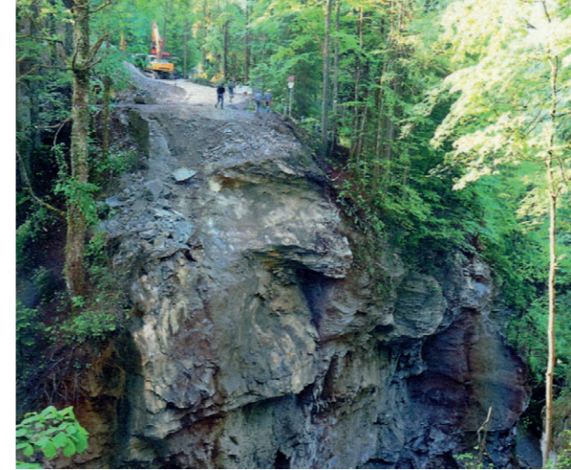
Abbruchstelle Felssturz Rappenloch 2011 | Foto: Amt Stadt Dornbirn
