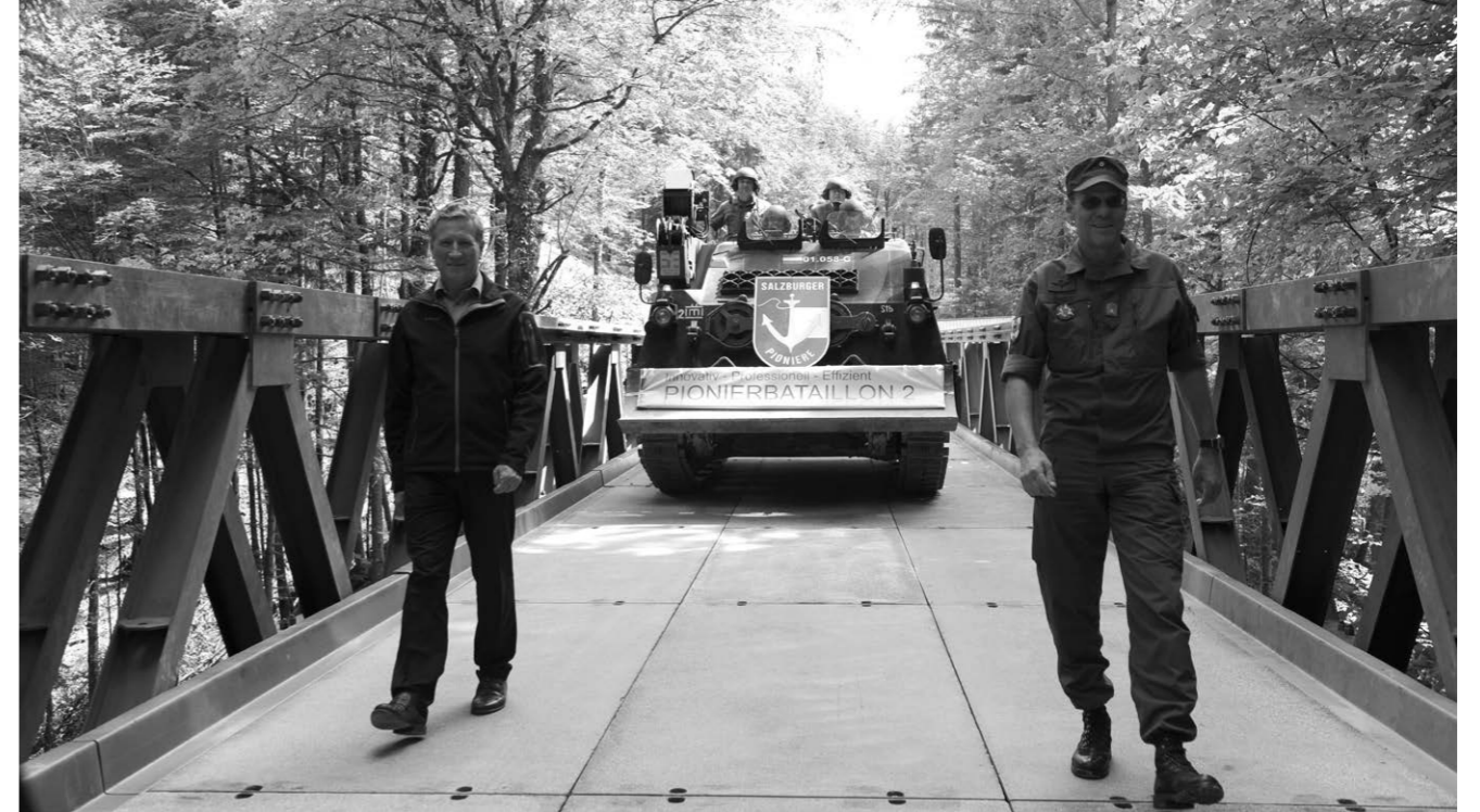
Erstes Fahrzeug auf der Pionierbrücke: der 50 Tonnen schwere Bergepanzer | Bildquelle: Stadtarchiv Dornbirn
