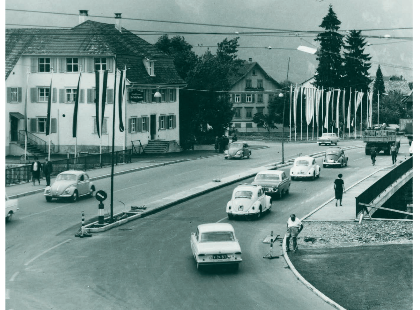
Die Sägerbrücke kurz nach der Eröffnung der zweiten Fahrspur im Sommer 1963 | Foto: Stadtarchiv, Sign. 62973
