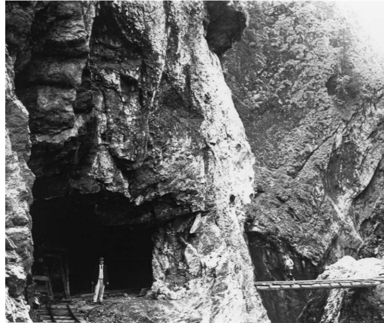
Bau der Ebnerstraße in den 1920er-Jahren, aufgenommen von Julius Diem | Foto: Stadtarchiv, Sign. R 175
