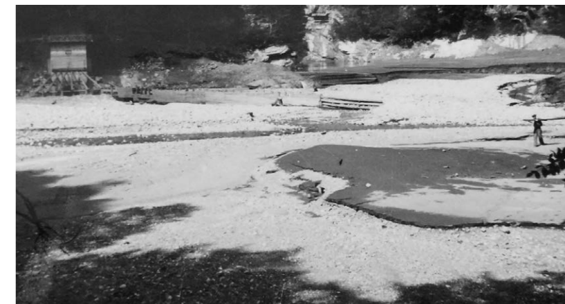
Juni 1940, Staufensee verschlammt | Foto: Bauamt
