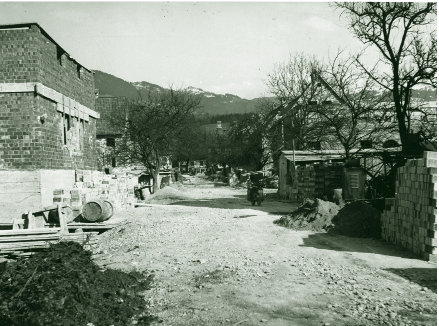
Siedlung Sala im Bau - Ende April 1940
