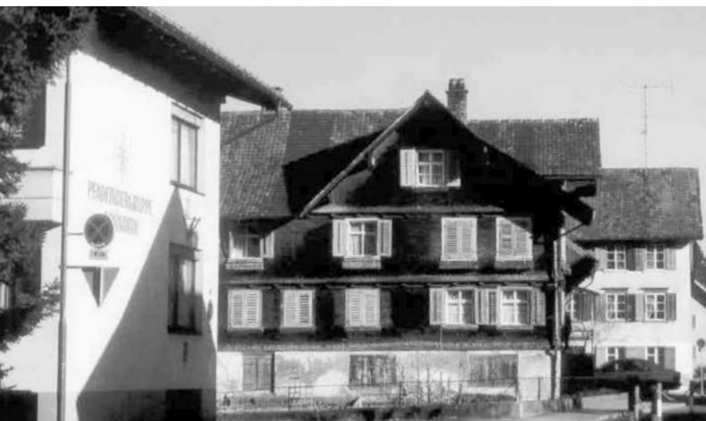
Die Feilenhauererei Bröll im Haus Schulgasse 58, das vor kurzem abgerissen wurde | Foto: Fa. Bröll
