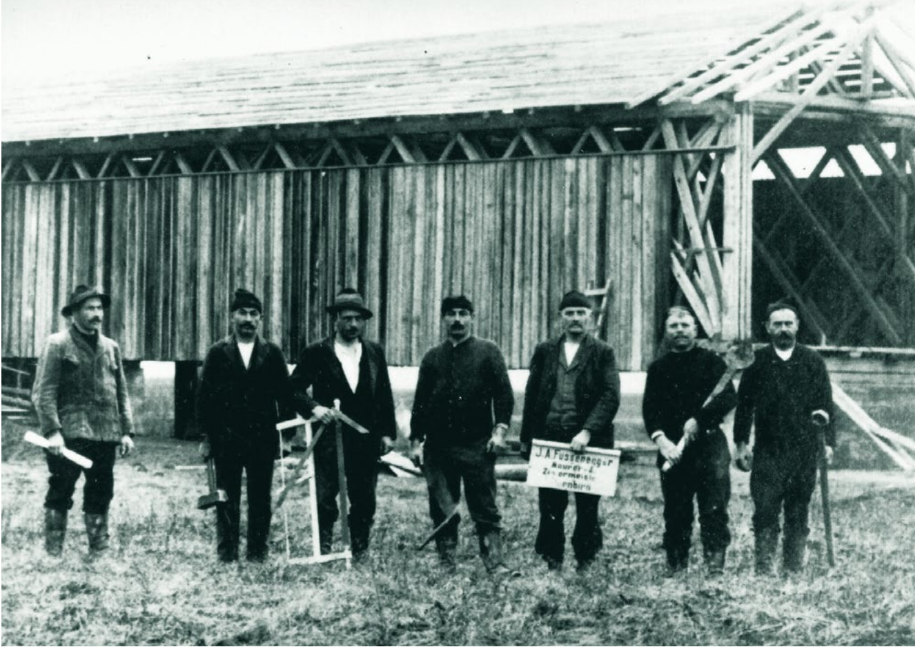
Bau oder Umbau der Senderbrücke
