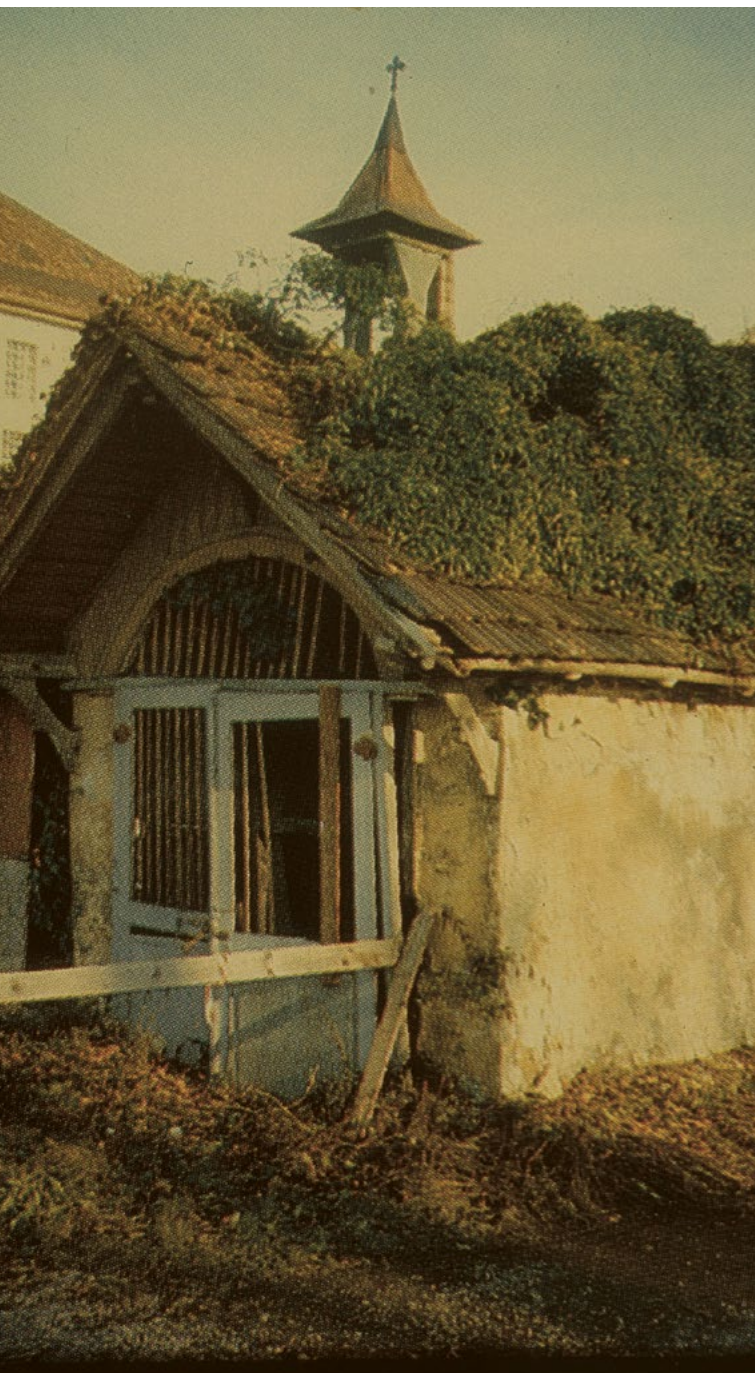
Die alte Kapelle Sägen vor Abbruch
