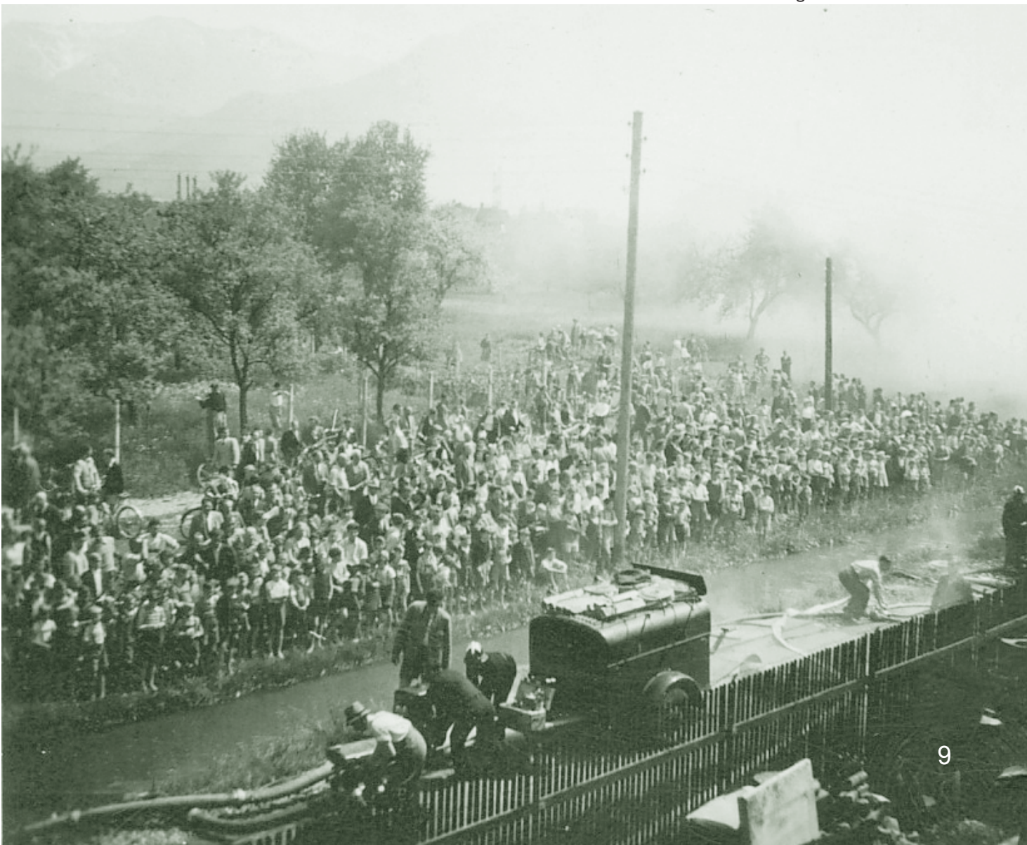
1950: Brand in der Alemannia Gummifabrik in der Kanalgarbe am Müllerbach
