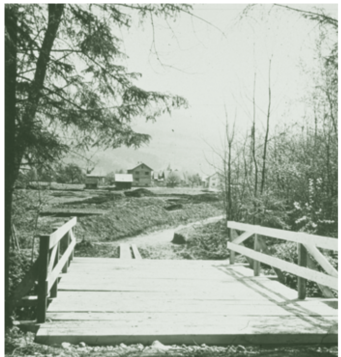
Behelfsbrücke im Rohrbach
