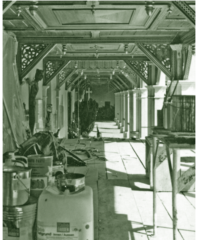
Restaurierung der Arkaden - 1980er
