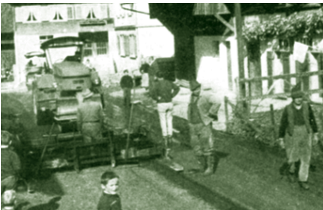
Asphaltierungsarbeiten in der Haslachgasse
