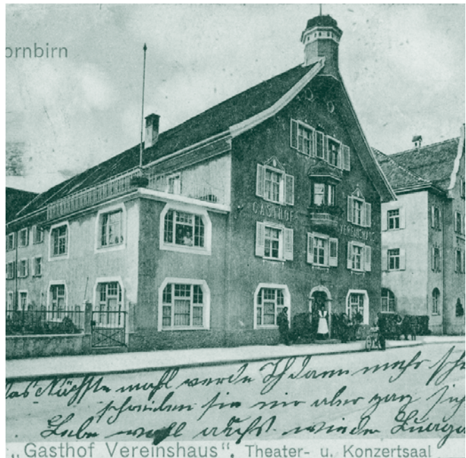
Vereinshaus und Arbeiterheim in der Schulgasse
