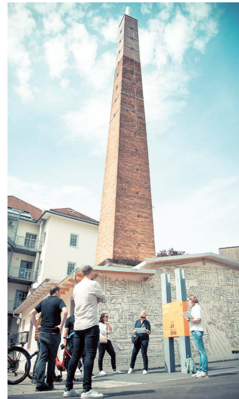
Station Nr. 7 – Sägen: Hier befand sich der größte Websaal Österreichs mit über 500 Webstühlen. | Foto: MEDIART/Andreas Uher
