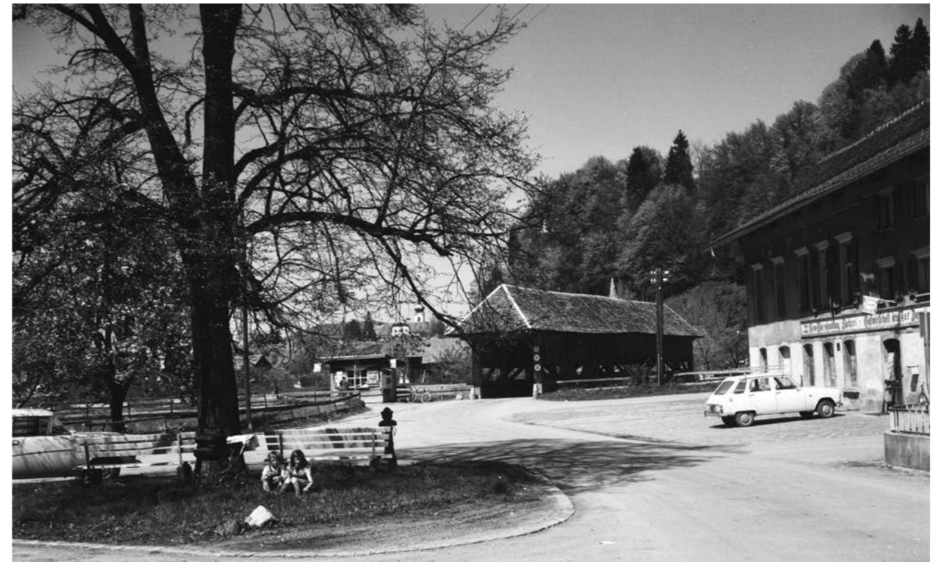
In der Hinteren Achmühle: In der Bildmitte ist die alte Holzbrücke (Danner Brücke) zu sehen, rechts das Gasthaus Zum Danner. Die Aufnahme dürfte Ende der 1960er entstanden sein. | Foto: Stadtarchiv, Bestand Bauamt, Sign. 63250-02
