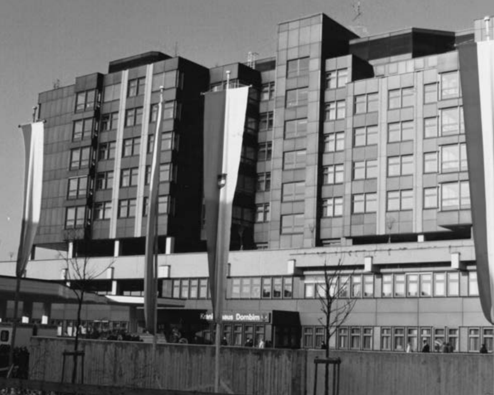
Blick von der Lustenauerstraße auf das städtische Krankenhaus bei der Einweihung | Foto: Stadtarchiv Dornbirn
