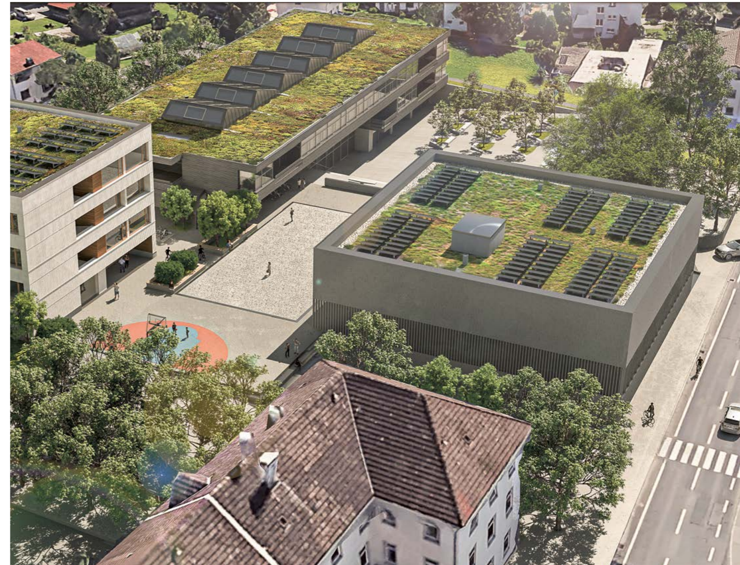
In Haselstauden entsteht derzeit ein neues Bildungszentrum. | Foto: Stadt Dornbirn
