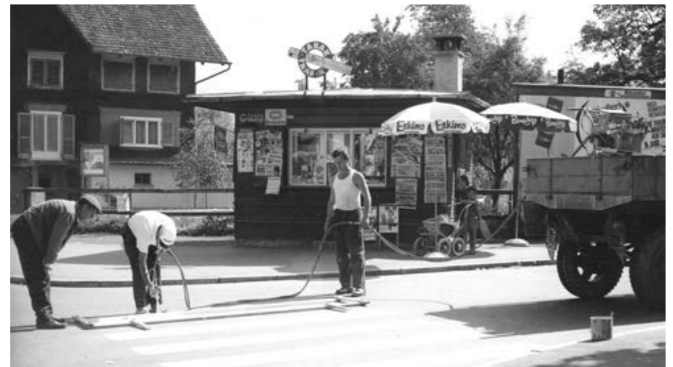
Straßenmarkierungsarbeiten vor dem Kiosk Hatlerstraße/Unterer Kirchweg, 1965 | Foto: Stadtarchiv, Sign. 59846
