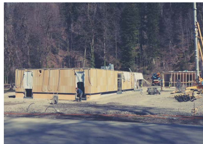
CAMPINGPLATZ IN DER ENZ – BAUSTELLE
