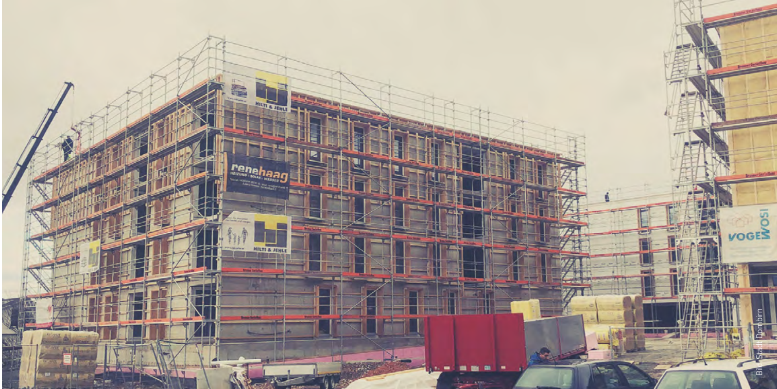
DIE NEUE WOHNANLAGE DER VOGEWOSI IN KASTENLANGEN WIRD HEUER BEZUGSFERTIG SEIN.
