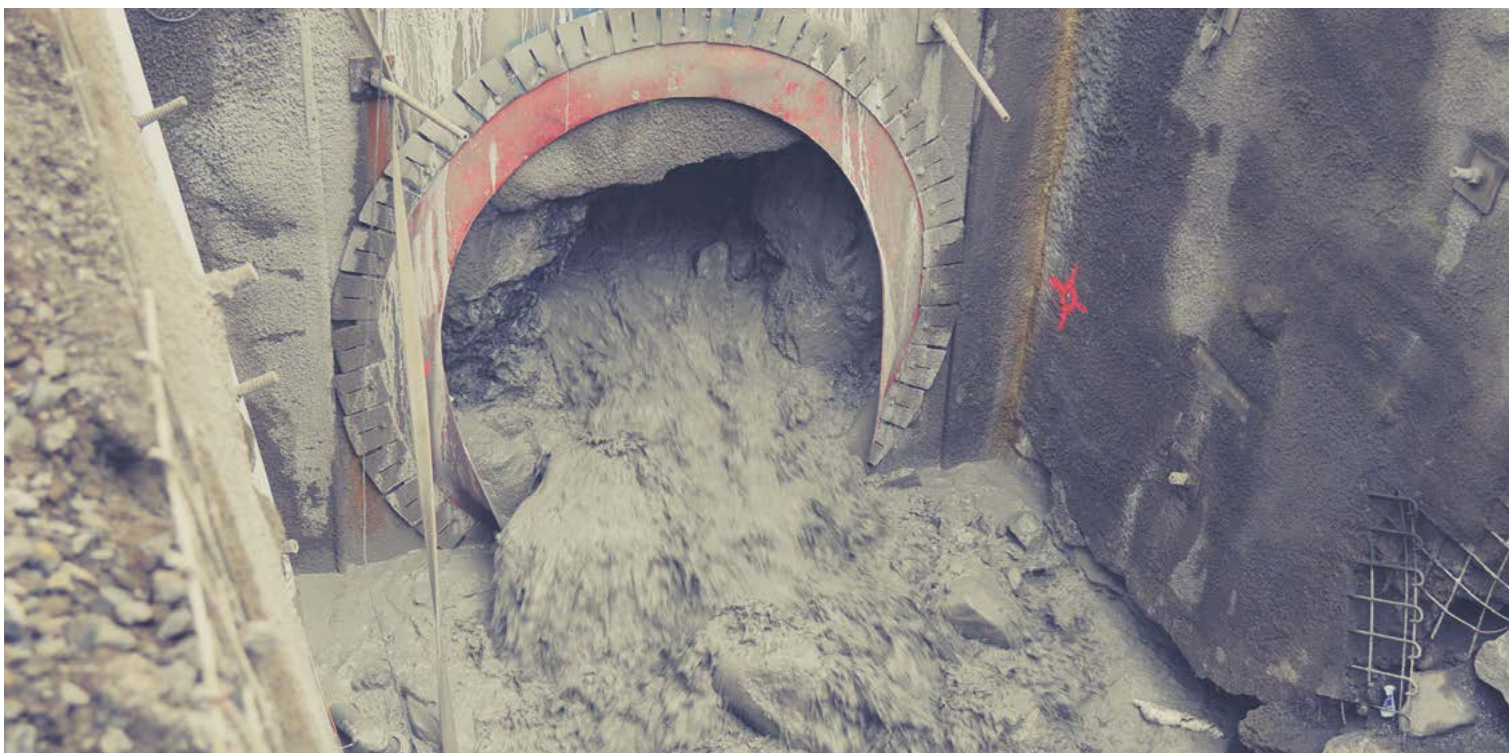
MIT DEM DURCHSCHLAG AUF DER ANDEREN SEITE DES ZANZENBERGS WURDEN DIE TUNNELARBEITEN ABGESCHLOSSEN.
