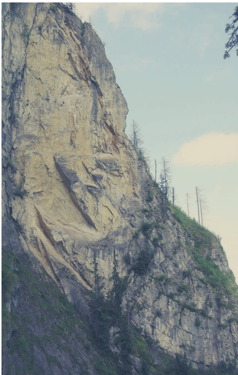
DIE GELBE WAND STEHT STABIL. | FOTO: STADT DORNBIERN
