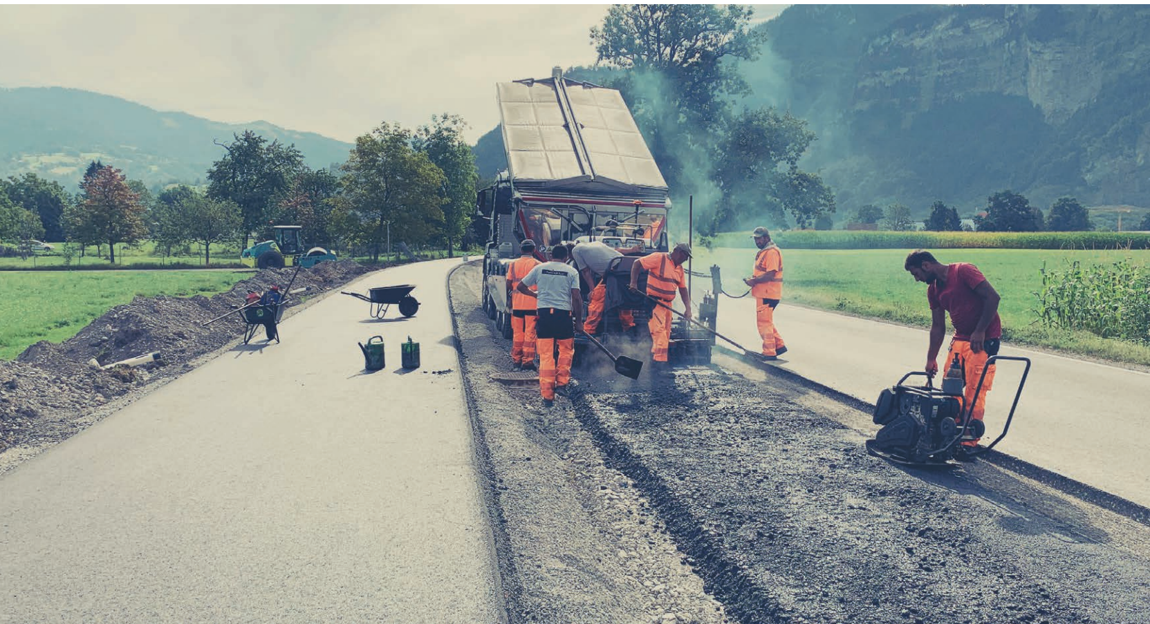
DER ERSTE ABSCHNITT DER NEUEN BLEICHESTRASSE IST FERTIG. 2021 ERFOLGEN DIE ARBEITEN AM NEUEN AUTOBAHNANSCHLUSS. | FOTO: STADT DORNBIRN
