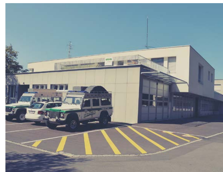
ZUBAU BEI DER RETTUNGSZENTRALE | FOTO: STADT DORNBIRN
