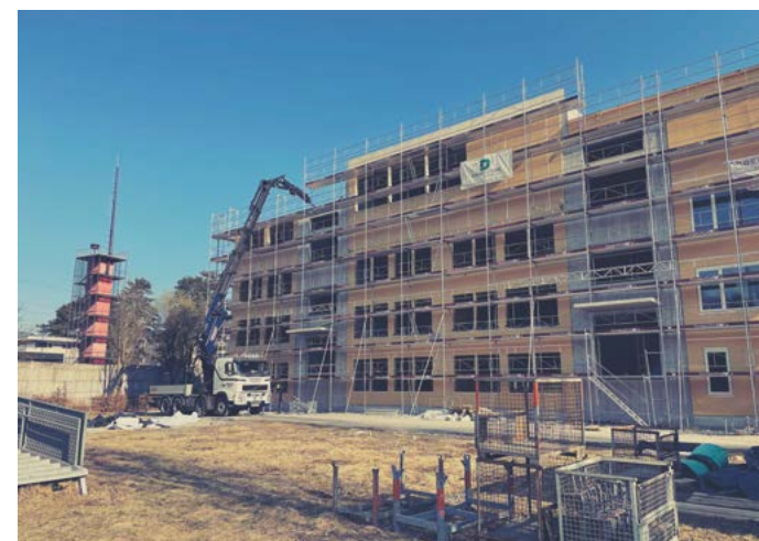
SYSTEMBAUWEISE MIT HOLZ ERMÖGLICHT AUFBAU IM EILTEMPO. | FOTO:STADT DORNBIERN
