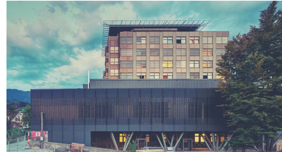
DAS GROSSMASCHIGE STRECKMETALL DER FASSADE LÄSST NATÜRLICHES LICHT IN DEN OP-BEREICH UND IST EINE VERBINDUNG NACH AUSSEN. | FOTO: WOLFGANG C. RETTER
